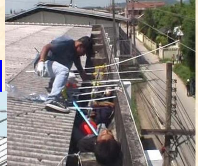
ไฟช้ตขณะติดตั้งแผงทิว
